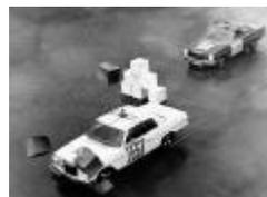
**Coupé Mercedes-Benz 'Barra Otto' della serie 114 dotato di sistema antibloccaggio Teldix (ABS) sulla rampa di accesso di Untertürkheim, 1970. Nella frenata in curva, l'auto dotata di ABS segue la sua traiettoria, mentre la vettura senza ABS esce di strada quando viene premuto con eccessiva forza il pedale del freno.**
